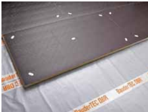
Saumbefestigung (Lineare Befestigung)
