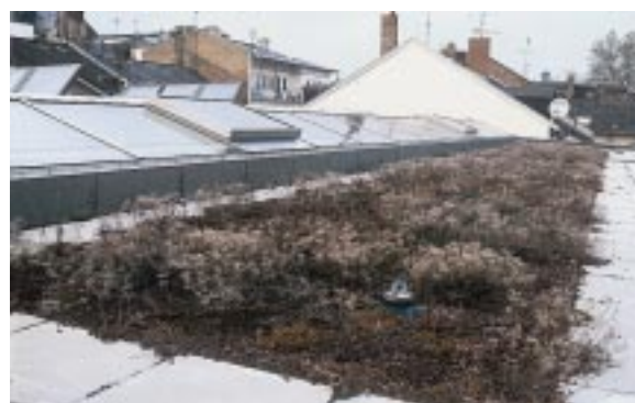
Selbst im November sind 20 Monate nach der Aussaat 90 % Flächendeckung vorhanden. Die üppigen Blütenstände lassen ahnen, welches farbenfrohe Bild das Dach zur Blütezeit bietet.
