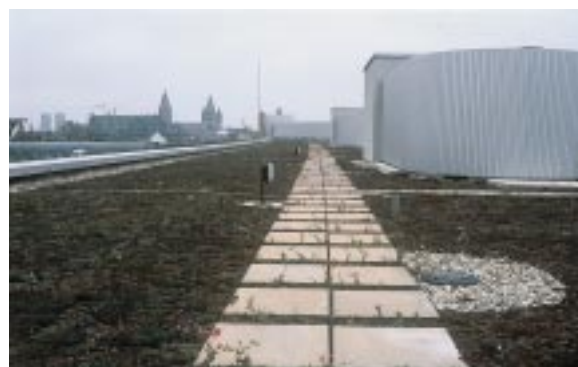
Das Dach des gestreckten Baukörpers ist ca. 200 m lang.
