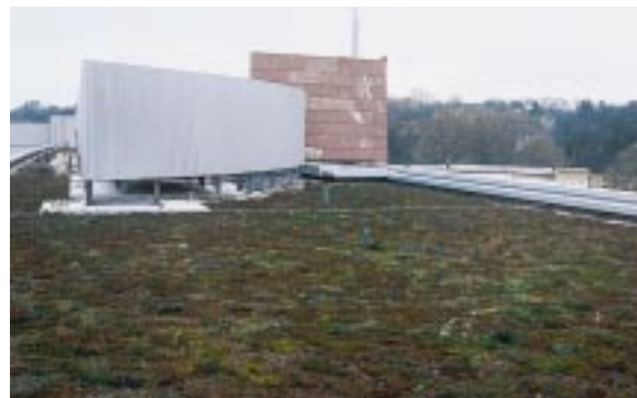
Die Dachfläche vom DB Cargo: Trotz der im November reduzierten Vegetation ist der abnahmefähige Zustand erreicht.
