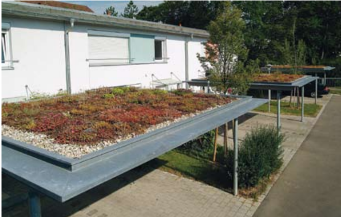
▲ Bei kleinen Dachflächen wie diesen Carports kann der Dachdecker die Extensivbegrünung komplett in Eigenregie ausführen
