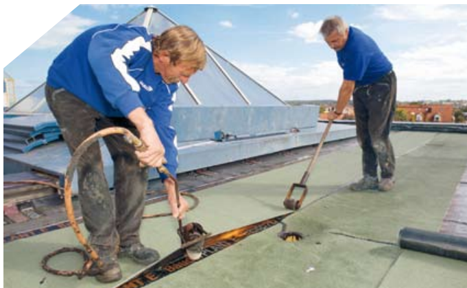
▲ Der erste Schritt zum Gründach ist die Verlegung einer durchwurzelungsfesten Flachdachabdichtung
