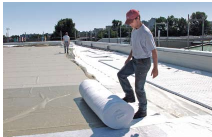
▲ Über der Abdichtungsbahn wird anschließend meist eine vollflächige Vliessschicht verlegt
