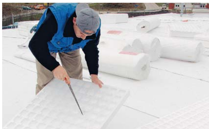
▲ Die Wasserspeicherplatten bestehen aus Polystyrol und lassen sich daher mit der Säge leicht auf Maß bringen
