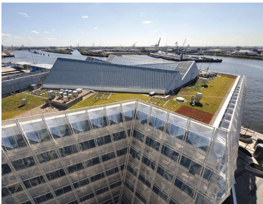
▲ Das neue Unilever-Haus am Hamburger Hafen hat ein Flachdach, das zum großen Teil extensiv begrünt ist und daher nur sehr wenig Pflege benötigt
