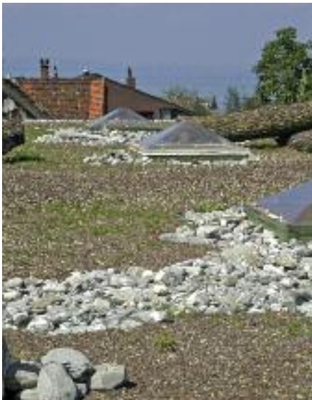
Ökodach mit Label. In einer Lebenszyklusanalyse wurde das System und seine Komponenten von der Rohstoffgewinnung bis zur Entsorgung ökologisch bewertet. Ergebnis: Der Begrünungsaufbau erfüllt die hohen Qualitätsanforderungen der SFG.
