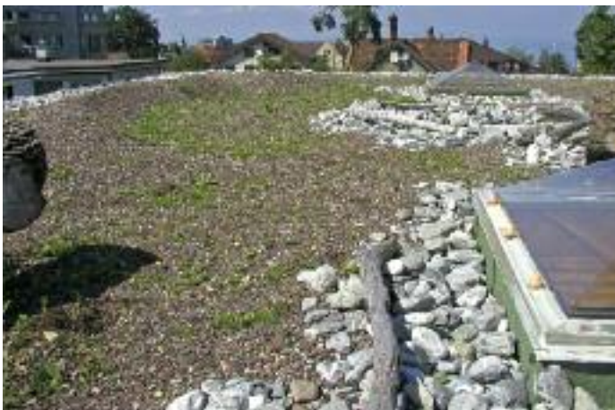
Ökodach mit Label. In einer Lebenszyklusanalyse wurde das System und seine Komponenten von der Rohstoffgewinnung bis zur Entsorgung ökologisch bewertet. Ergebnis: Der Begrünungsaufbau erfüllt die hohen Qualitätsanforderungen der SFG.
