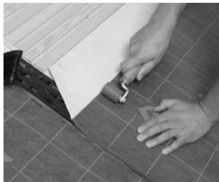
BauderTOP DIFUBIT NSK auf BauderTEC PMK aufkleben und anrollen
