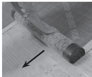
Verlegung in der Fläche immer Traufe - First
