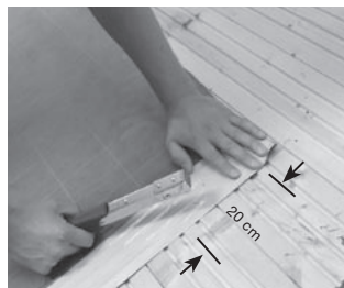
Bahn im Nahtbereich mechanische befestigen
