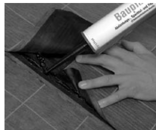
Zusätzlich Klebmasse BauderColl oder Bauplast P im linken Eckbe- reich auftragen
