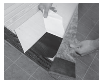
Unteren Teil der BauderTEC PMK Folie herausziehen
