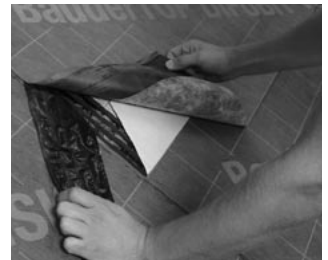
Nahtabdeckstreifen herausziehen
