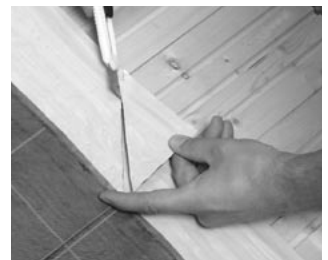
Nahtabdeckstreifen dreiecksförmig einschneiden
