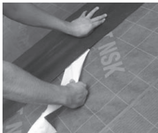
Linken und rechten Nahtab- deckstreifen des Bauder Kappstreifen SK herausziehen
