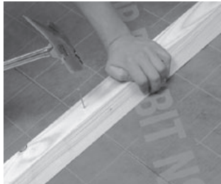
Trapezförmige Konterlatten entsprechend ZVDH-Fachregeln aufnageln
