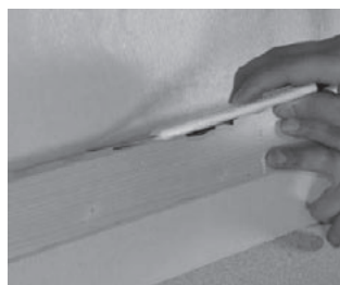
1,25 m von BauderTEC PMK abschneiden, rückseitige silikonisierte Folie halbieren
