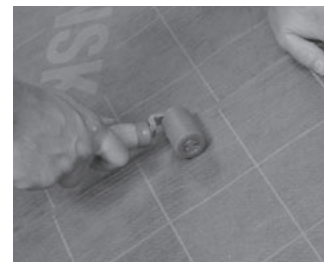
Naht schließen und anrollen
