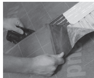
Nahtabdeckstreifen abziehen bis ca. 20 mm unterhalb des Kopfstoßes
