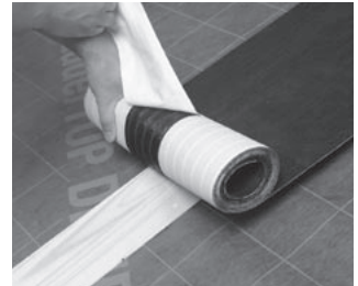
Mittleren Teil der Abdeckfolie des Bauder Kappstreifen SK abziehen und auf der Konterlatte aufkleben
