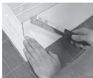
BauderTEC PMK-Streifen im oberen Randbereich mechanisch befestigen
