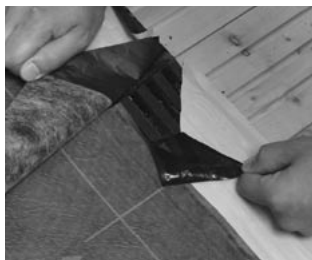
Dreiecksförmig eingeschnittenen Nahtabdeckstreifen abziehen
