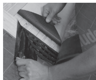
Nahtabdeckstreifen ca. 20 cm nach oben abziehen
