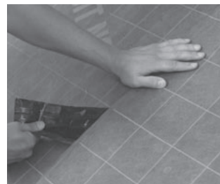
Nahtabdeckstreifen herausziehen und mit Heißluft aktivieren / verschweißen
