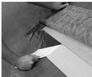
Oberen Folienteil von BauderTEC PMK abziehen
